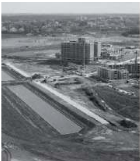
Construction du Canal, Courcouronnes
